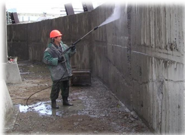
Рис. 2.1.1 Очистка и увлажнение поверхности гидромонитором
