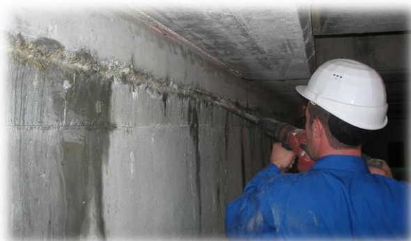
Рис. 2.1.2 Расшивка перфоратором «холодного шва бетонирования»
